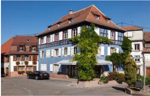
Situation depuis 1689 13, place du Marché
